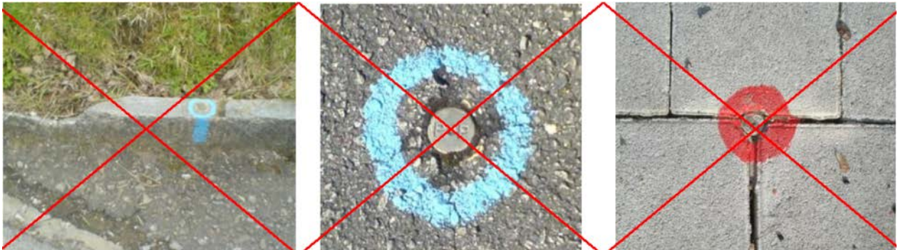
Abbildung 7: links: unzulässiger Bolzen in Randstein (Randsteinfuge zugelassen); mitte: unzulässiger Bolzen in Asphalt-Strassenbelag; rechts: unzulässiger Bolzen in Verbundsteinen
