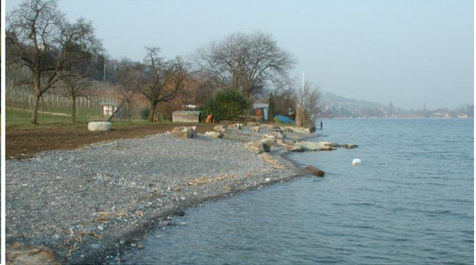
Eine Kiesschüttung stabilisiert das Ufer dauerhaft. Die Wellenenergie wird in der Brandung sanft gebrochen, eine Ufermauer ist nicht mehr nötig (links: Vierwaldstättersee – Urnersee, Flüelen; rechts: Vierwaldstättersee – Küsnachtersee, Meggen).
