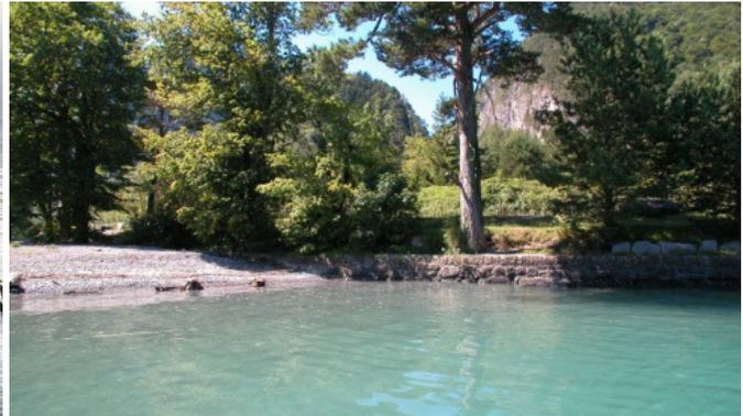
Mit sogenannten Buhnen (links) oder durch angrenzende Landvorsprünge (rechts) wird die Kiesschüttung seitlich stabilisiert und das uferparallele Verdriften des Kiesel durch die Wellen verhindert. (links: Bielersee, Erlach; rechts: Vierwaldstättersee – Urnersee, Isleten).
