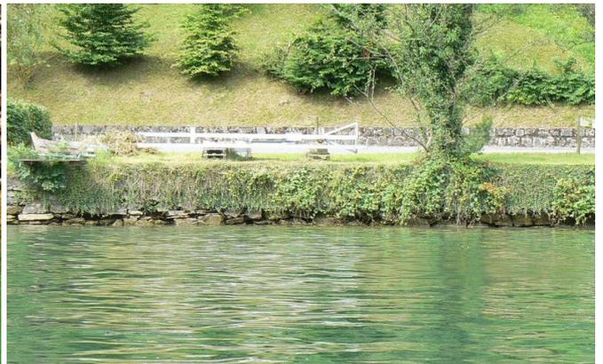
Der Mauerfuß sollte aus ästhetischen Gründen möglichst unter dem Niedrigwasserstand liegen und die Mauerkrone sollte möglichst tief gehalten werden. Je nach Situation (Wellenexposition und Schutzziel) sind allerdings verschiedene Mauerhöhen zu wählen (links: Vierwaldstättersee, Horw). Mauern, welche nur teilweise verputzt sind, bieten Unterschlupf für Kleintiere (rechts: Vierwaldstättersee, Horw).
