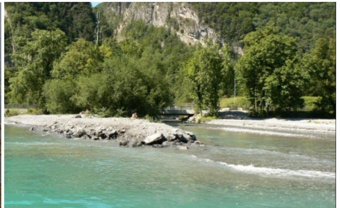
Mit dem Bau eines vorgelagerten Wellenbrechers wird das Flachufer zusätzlich vor Wellenerosion geschützt (links: Bielersee, Ipsach; rechts Vierwaldstättersee – Urnersee, Isleten).
