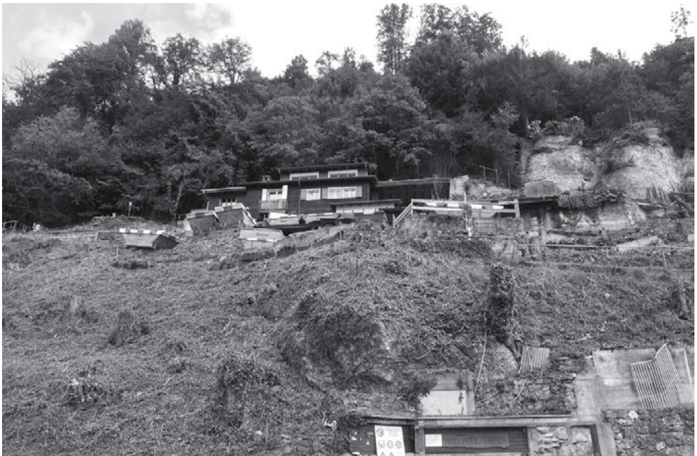
September 2015: Das letzte der fünf Wohnhäuser im Gebiet Horloui wird für den Rückbau bereit gemacht.
