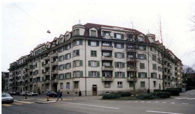
Vorher: Ansicht Nord-West (Quelle: bfe.admin.ch)
