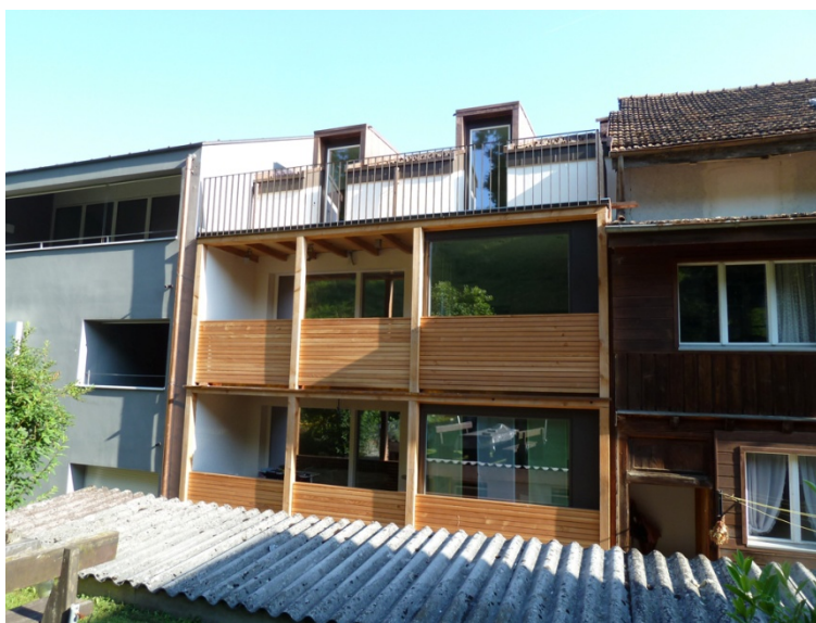
Rückseite mit Laube (Quelle: CAS Architekten)
