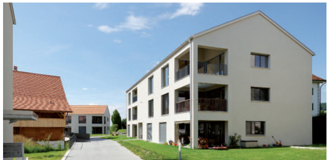
Hinter der Mühle (Quelle: CAS Architekten Sonderdruck)
