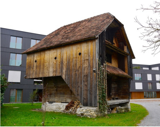
Spycher vor dem Neubau (Quelle: rawi)
