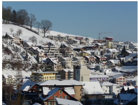
Rohbauten Dezember 2012 (Q.: STARAG Architekten AG)
