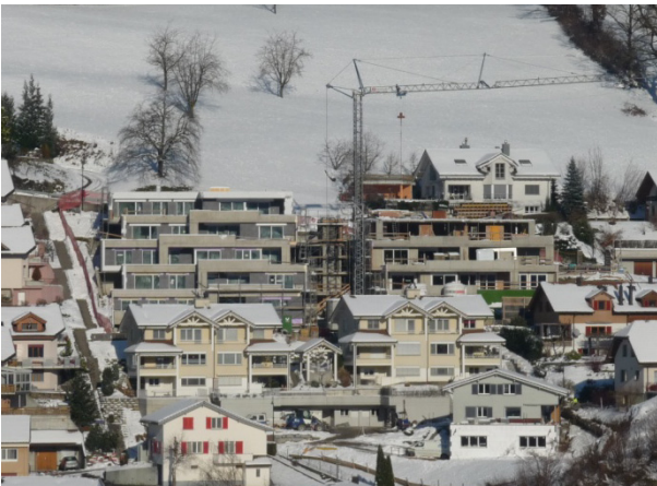
Rohbauten Dezember 2012 (Quelle: STARAG Architekten AG)
