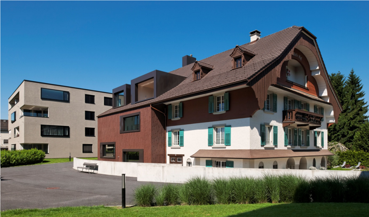
Mühlehof mit Anbau, links hinten Wohnüberbauung Mühlehof (Quelle: © Bruno Meier Sursee)
