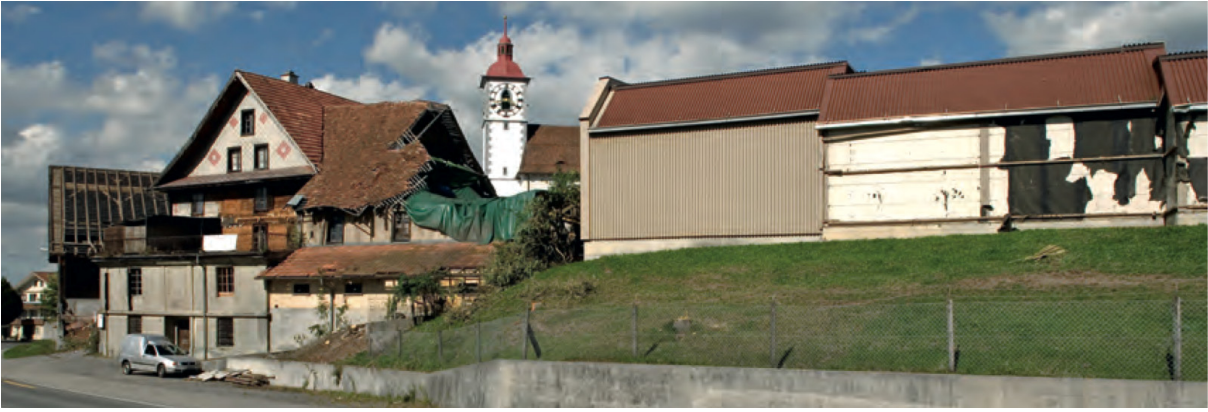
Mühle-Areal vorher (Quelle: CAS Architekten Sonderdruck: „Neudorf Dorfmühle im Ortskern“ von Claus Niederberger)
