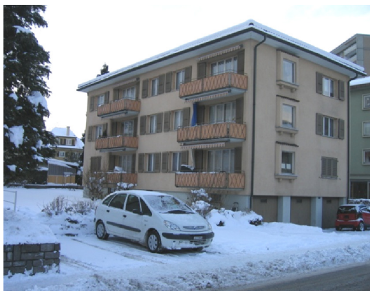
Vorher: Ansicht Süd (Quelle: Heller Architekten GmbH)
