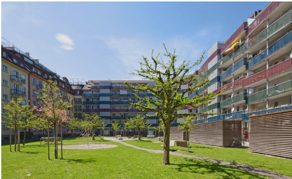
Innenhof mit den neuen Balkonen
