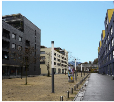
Baufelder 4, 5 und 6 (Quelle: rawi)
