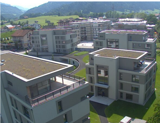
Blickrichtung Süd, vorne links: Gebäude C4
