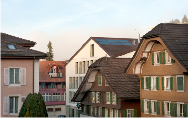
Schützenhaus (Quelle: GKS Architekten + Partner AG)
