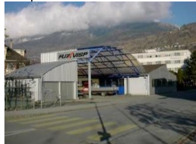
Unterstände Tiefe > 4.00 m
