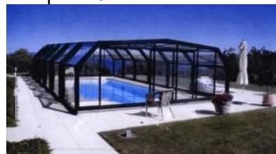
Massiv und tlw. fest mit dem Boden verbundene Bassin-Überdachung. Versetzungen generalisieren (siehe auch Kap. 3.1.1.2)
