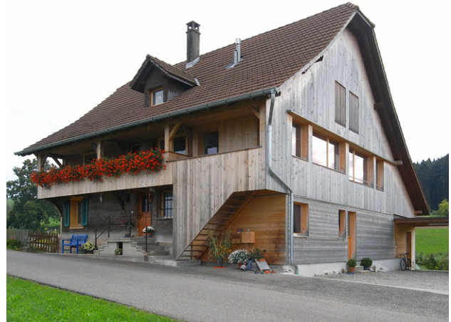
Gut gelöste Erschliessung im Laubenbereich
