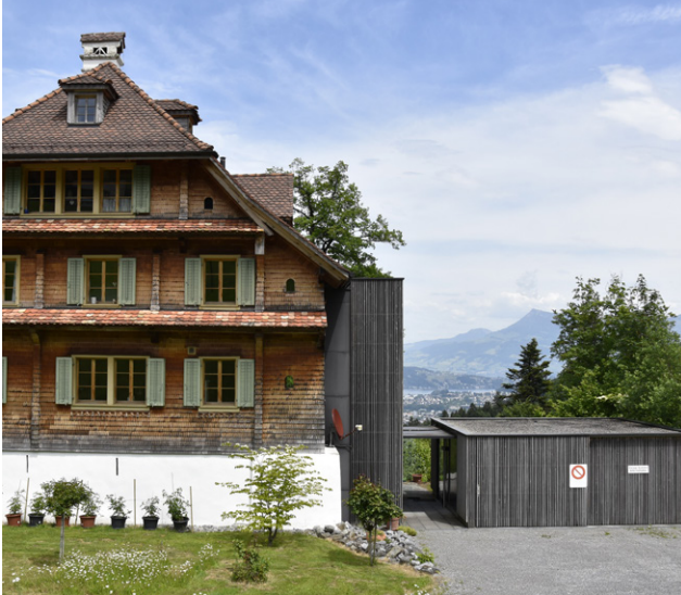
Treppenaufgang an das Gebäude angebaut
